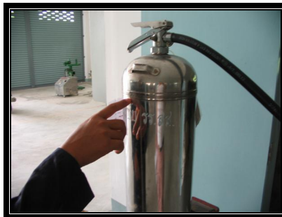
รูปที่ แสดงการตรวจถังน้ำดับเพลิง
