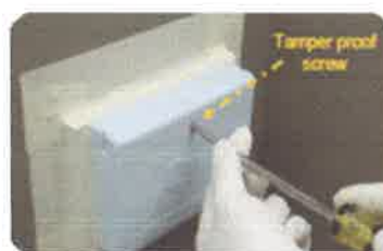
ทำการปิดกล่องโดยใช้สกรูขันแล้วใช้เทปกาวปิดบริเวณรอบ ๆ กล่องเพื่อป้องกันลมเข้าไปในกล่อง
