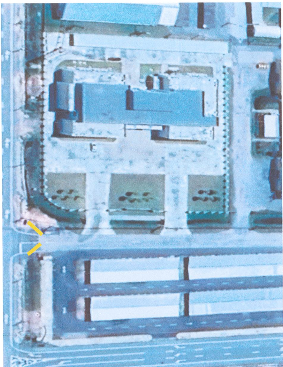
จุดติดตั้งไม้กั้น บริเวณทางเข้าลานจอดรถ ๒
